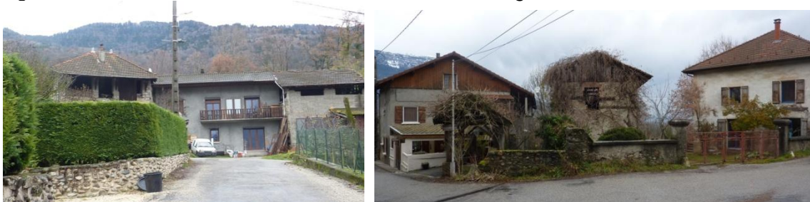
Figure 45 Maisons anciennes et récentes en mélange à la Perrière
