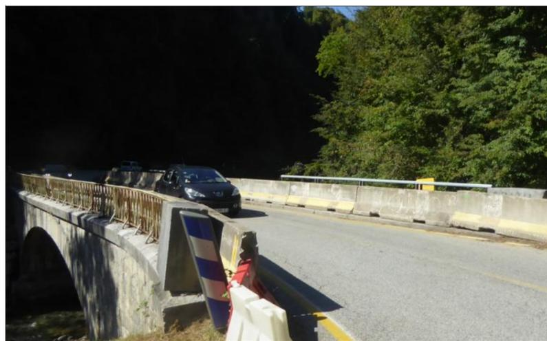
Au final, la plateforme routière comprendra une chaussée de 6 mètres de largeur, une bande cyclable de 1,20m dans le sens montant, un nouveau dispositif de retenue en bordure de route et un fossé de 0,80 m de largeur au pied du talus rocheux.
